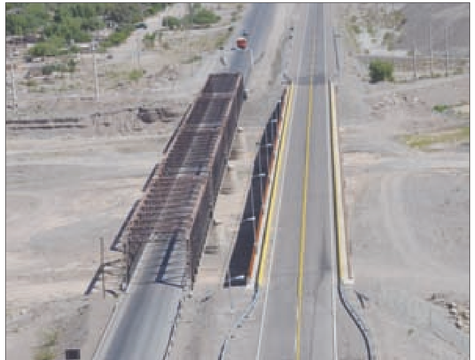
Puente de Albardón
