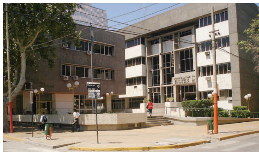
Un municipio nuevo. En los años 70, el llamado neo-brutalismo arquitectónico tiene sus manifestaciones en dos importantes obras: la Municipalidad de la Capital y el Centro Cívico. El edificio de la Municipalidad de la Capital de San Juan fue levantado entre 1971 y 1976. A diferencia de los de etapas anteriores, este fue proyectado por profesionales sanjuaninos.
