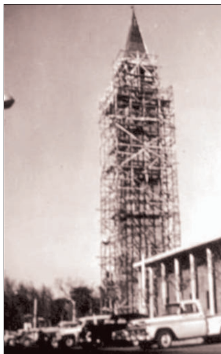
Varios años pasaron hasta que San Juan tuviera una nueva catedral. El conjunto fue construido en etapas. A fines de 1962 se terminaron la cripta y el campanil, en tanto la iglesia catedral y la casa parroquial se inauguraron en diciembre de 1979.
