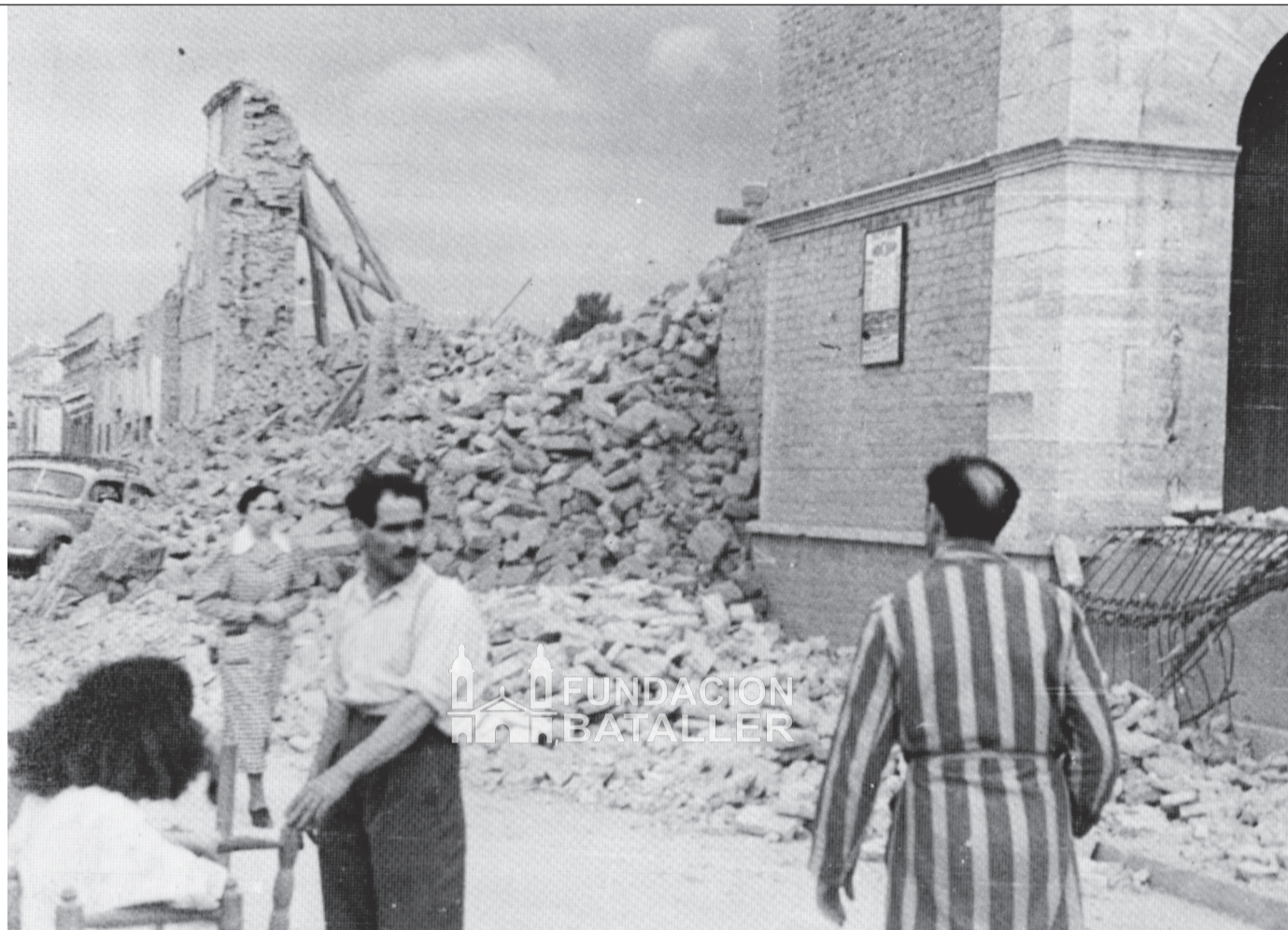
Calle Mitre casi esquina Mendoza. La ciudad de San Juan muy poco después del terremoto del 15 de enero de 1944. Un transeúnte deambula con su bata puesta. Otro hombre, con sus muebles en la calle, lo observa. Atrás, el paredón de la Iglesia de San Agustín sostenido por palos. (Foto publicada en el libro “Y aquí nos quedamos”, edición dirigida por Juan Carlos Bataller)
